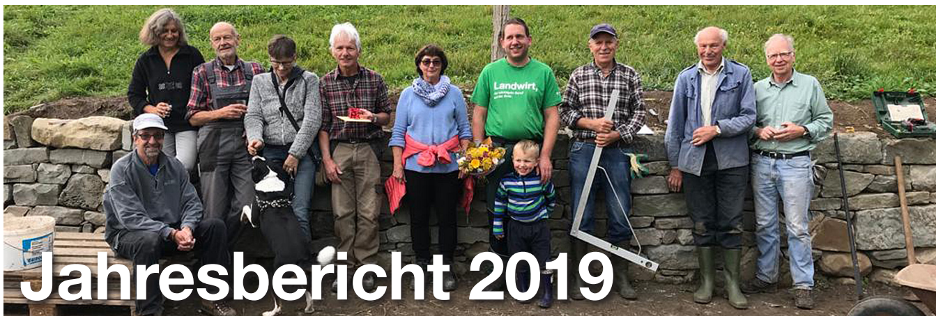
Wiederaufbau einer verfallenen Trockensteinmauer in Bonstetten
